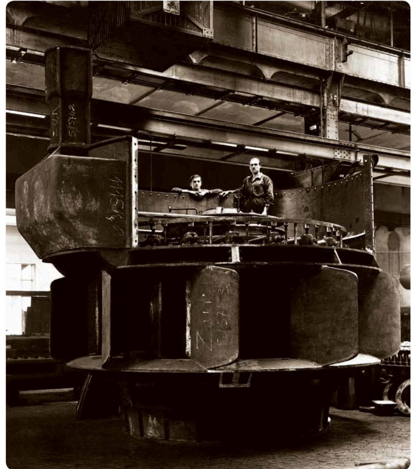
Budowa elektrowni wodnej Żur – montaż w fabryce (Austria) głównego kadłuba turbiny wodnej Kaplana, 1929 r. / Construction of the Żur hydropower plant – assembly of the main body of the Kaplan turbine at the factory (Austria), 1929 (arch. Photofactory®)
