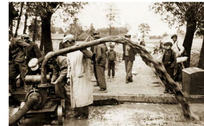
fot. Budowa Gazociągu Centralnego. Construction of the Central Gas Pipeline.
