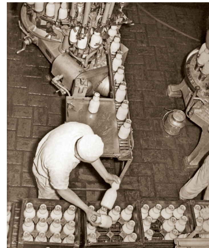
Taśma produkcyjna służąca do butelkowania mleka
