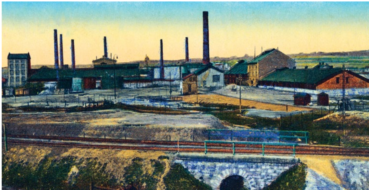
Rafineria Nafty w Trzebini (obecnie ORLEN Południe) / Oil Refinery in Trzebinia (today ORLEN Południe)
