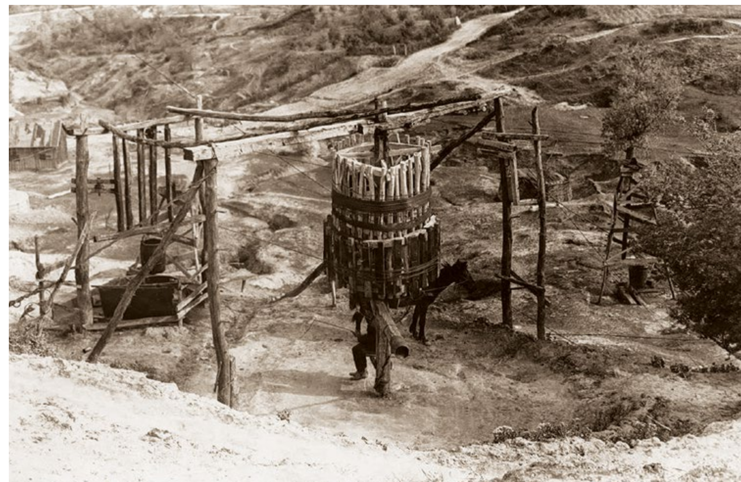
Kopalnia ropy w Moreni w Rumunii z pompą napędzaną kieratem / Oil mine in Morenia, Romania with a pump operated by a treadmill
