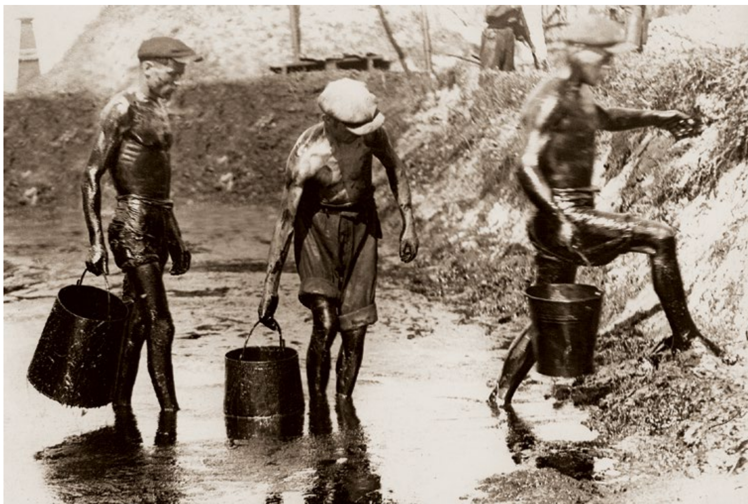
Najprymitywniejsze sposoby wydobycia ropy polegały na czerpaniu jej bezpośrednio z naturalnych wypływów lub też odsączaniu jej z wody przy pomocy sitowia lub końskiego włosia / The most primitive oil extraction methods comprised its direct drawing from natural surface spills or draining from water using rush or horsehair
