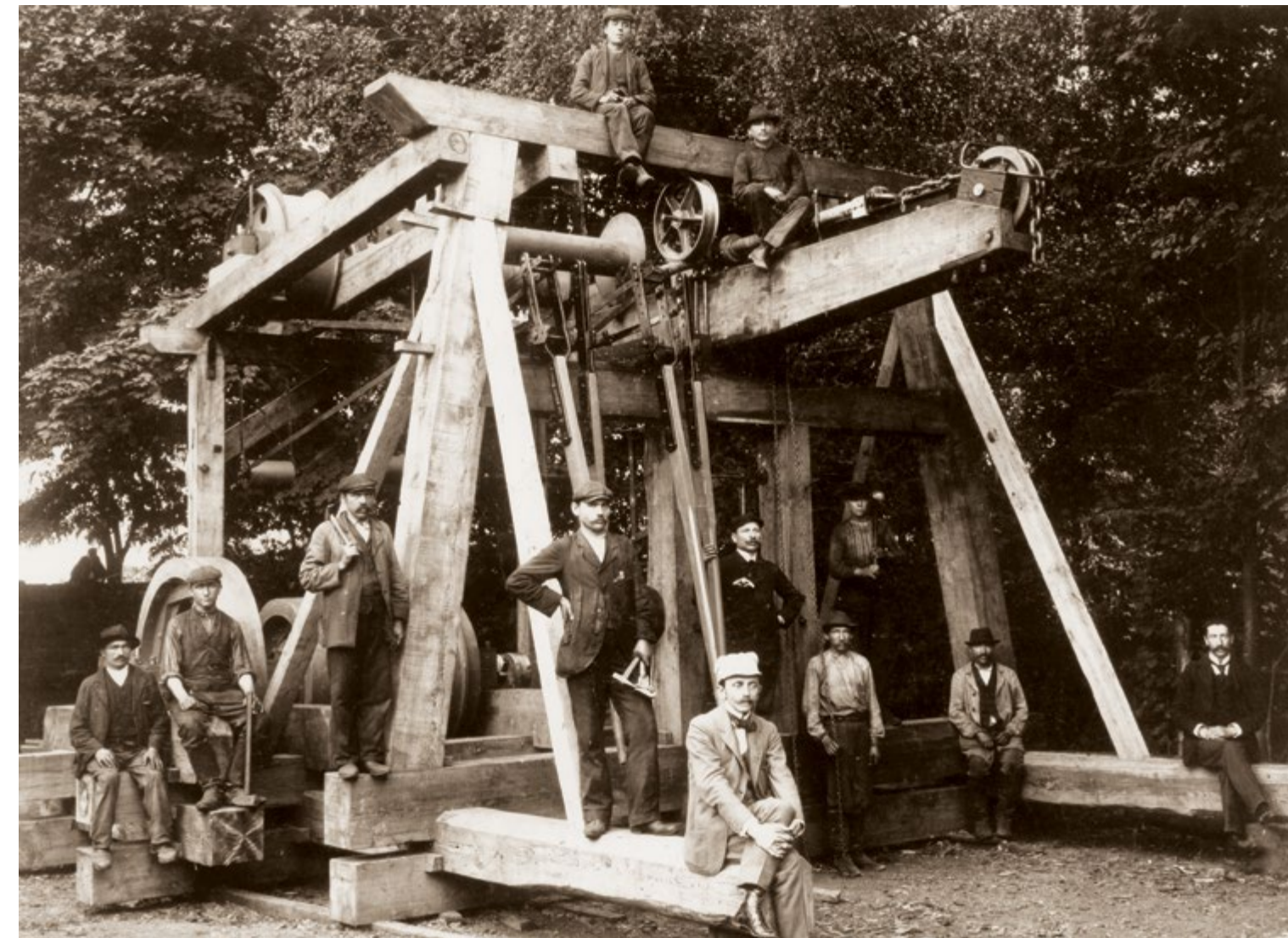
Ryg wiertniczy konstrukcji Leona Mikuckiego (na fotografii – siedzi na pierwszym planie) – Gorlice, ok. 1897 r. / Drilling rig designed by Leon Mikucki (in the photograph – sitting in the foreground) – Gorlice, ca. 1897
