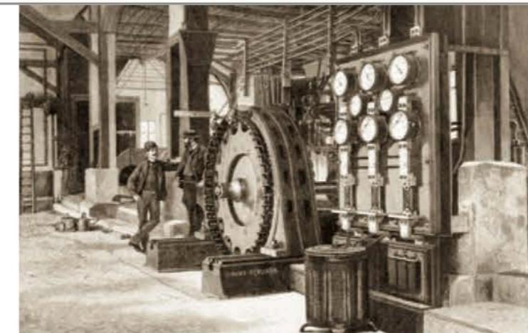
Trójfazowy generator w elektrowni Lauffen – dzieło M. Doliwo-Dobrowolskiego – 1891 r. / Three-phase generator in Lauffen power plant – work of M. Doliwo-Dobrowolski – 1891.
