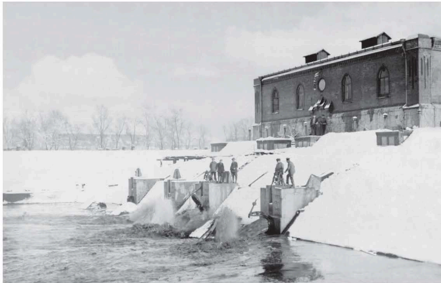
Spust osadów z odzależiacza przy zakładzie „Na Grobli” we Wrocławiu (arch. MPWiK Wrocław)
