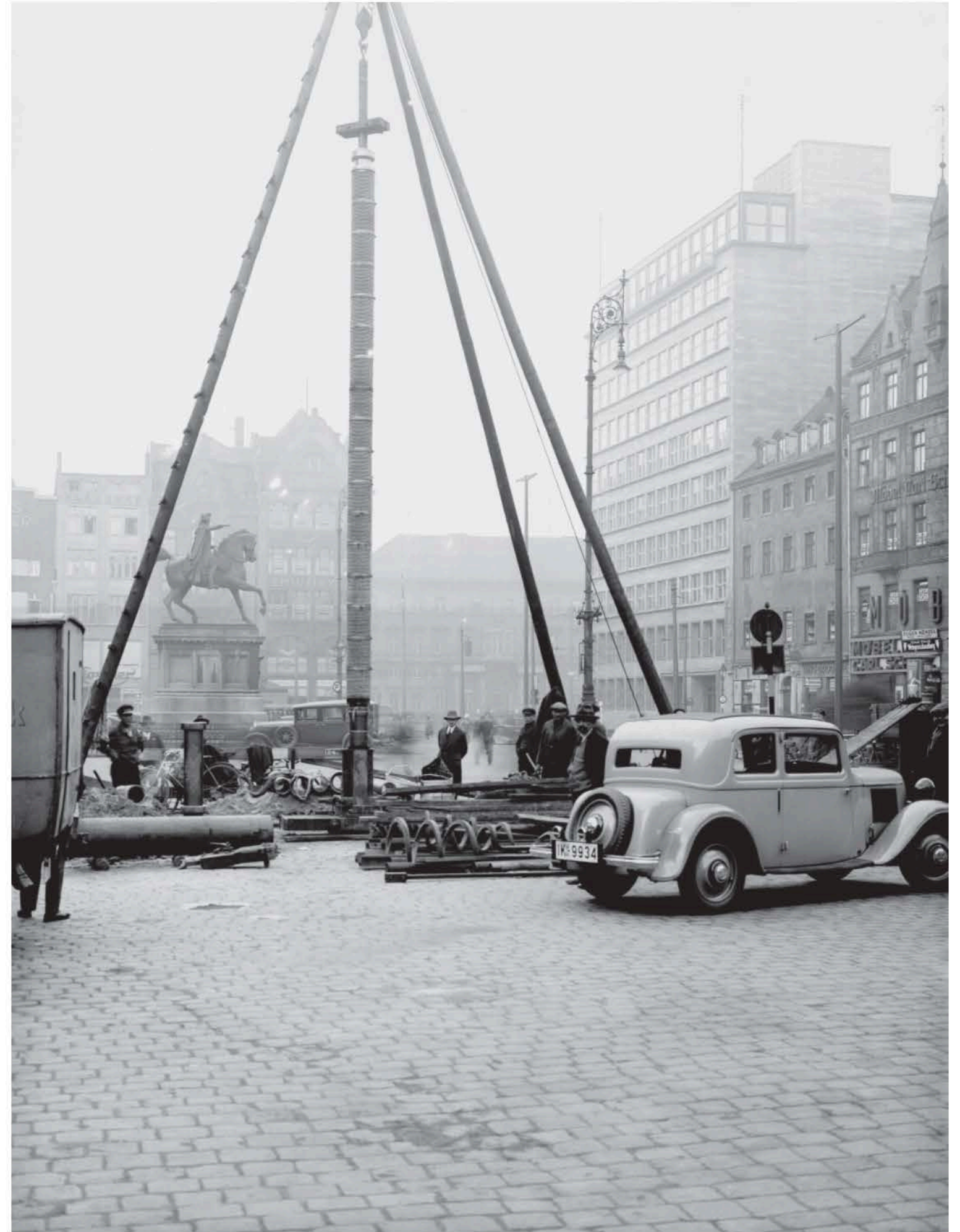
Prace wiertnicze przy studni publicznej na wrocławskim Rynku, lata 30. XX wieku (arch. MPWiK Wrocław)
