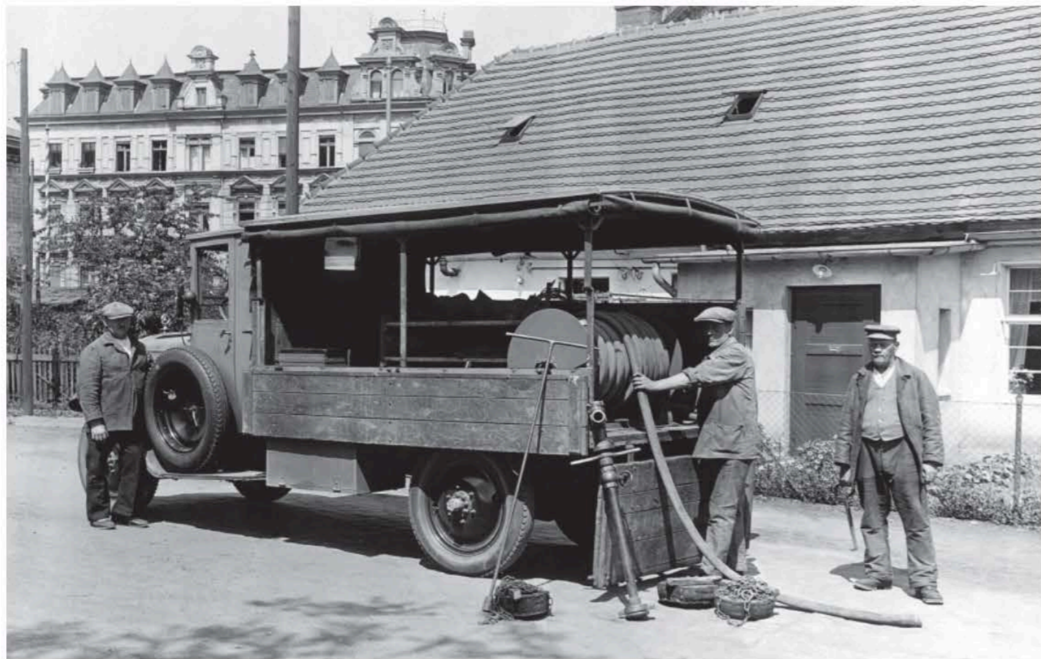
Jeden z pierwszych we Wrocławiu specjalistycznych samochodów do czyszczenia kanalizacji (arch. MPWiK Wrocław)
