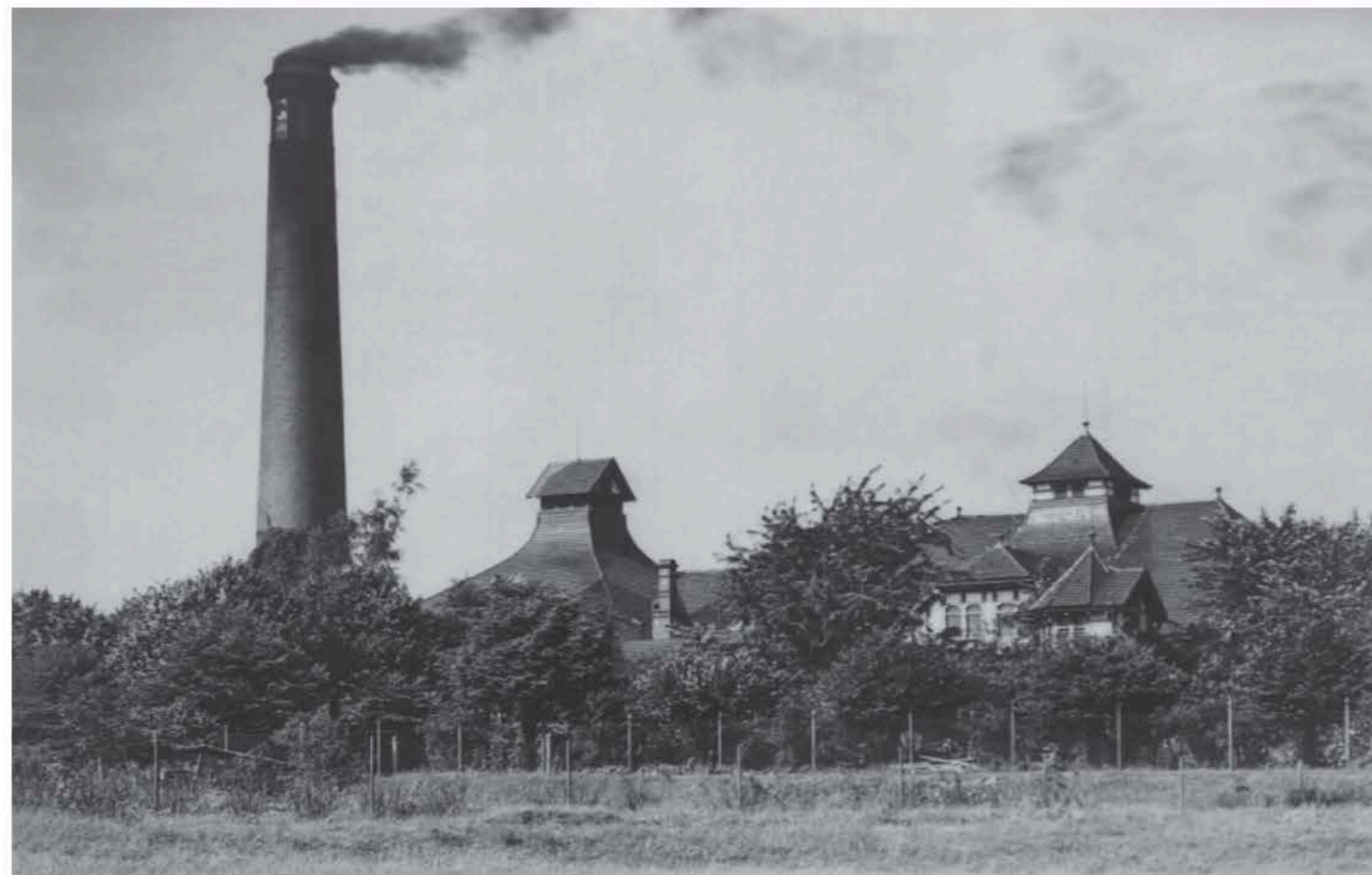
Pompownia „Świątniki” we Wrocławiu, wybudowana w latach 1902–1904 (arch. MPWiK Wrocław)
