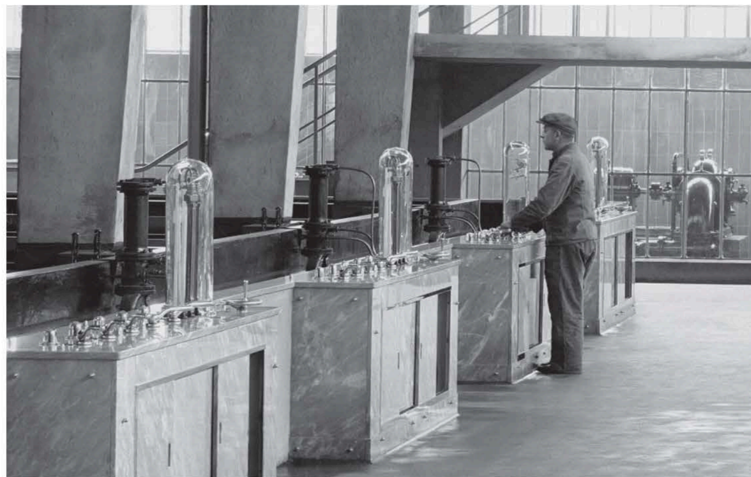
Pulpity sterownicze filtrów w zakładzie „Na Grobli” we Wrocławiu (arch. MPWiK Wrocław)
