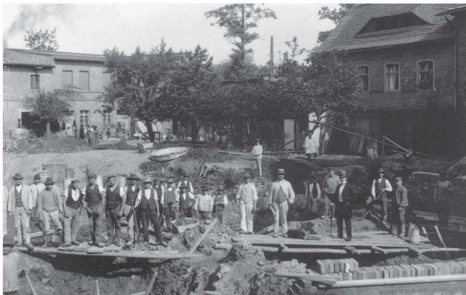
Zielona Góra. Budowa kanalizacji w rejonie Młyna Słodowego – 1928 r. (arch. Zielonogórskie Wodociągi i Kanalizacja)
