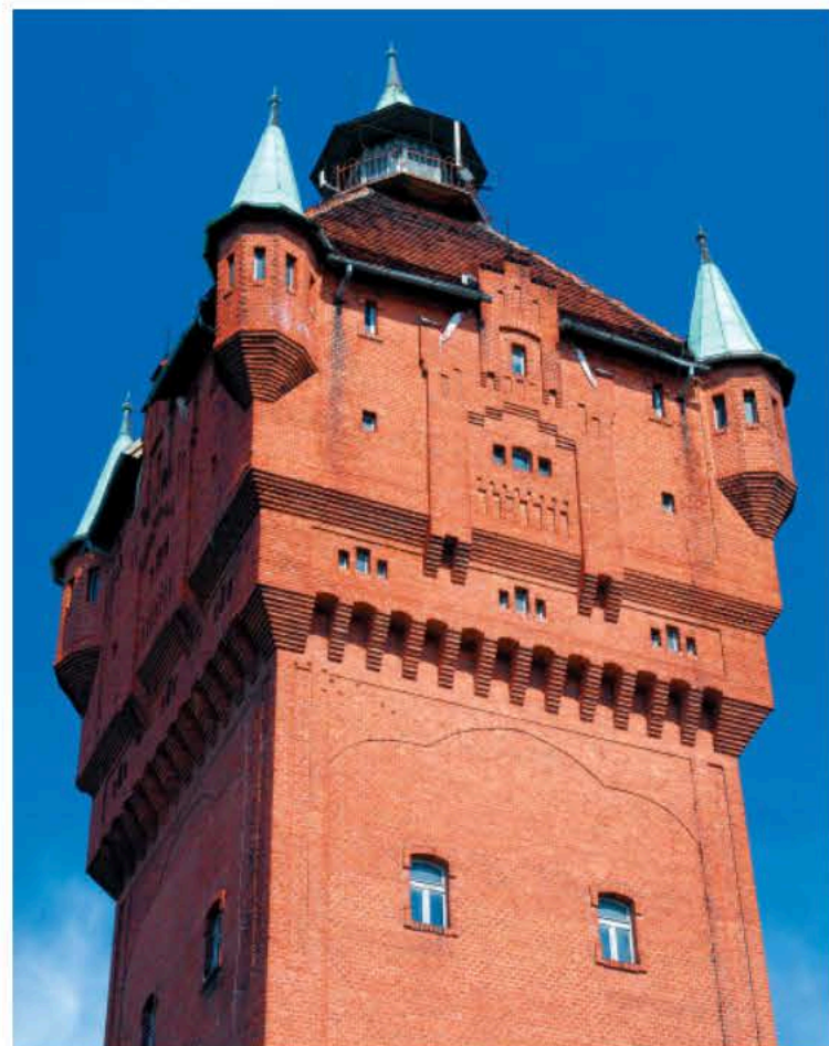
Śrem, woj. wielkopolskie – wieża wodociągowa (wysokość 44 m), zbudowana w 1908–1909 r. wg projektu K. Geislera (foto M. Kucharczyk)
