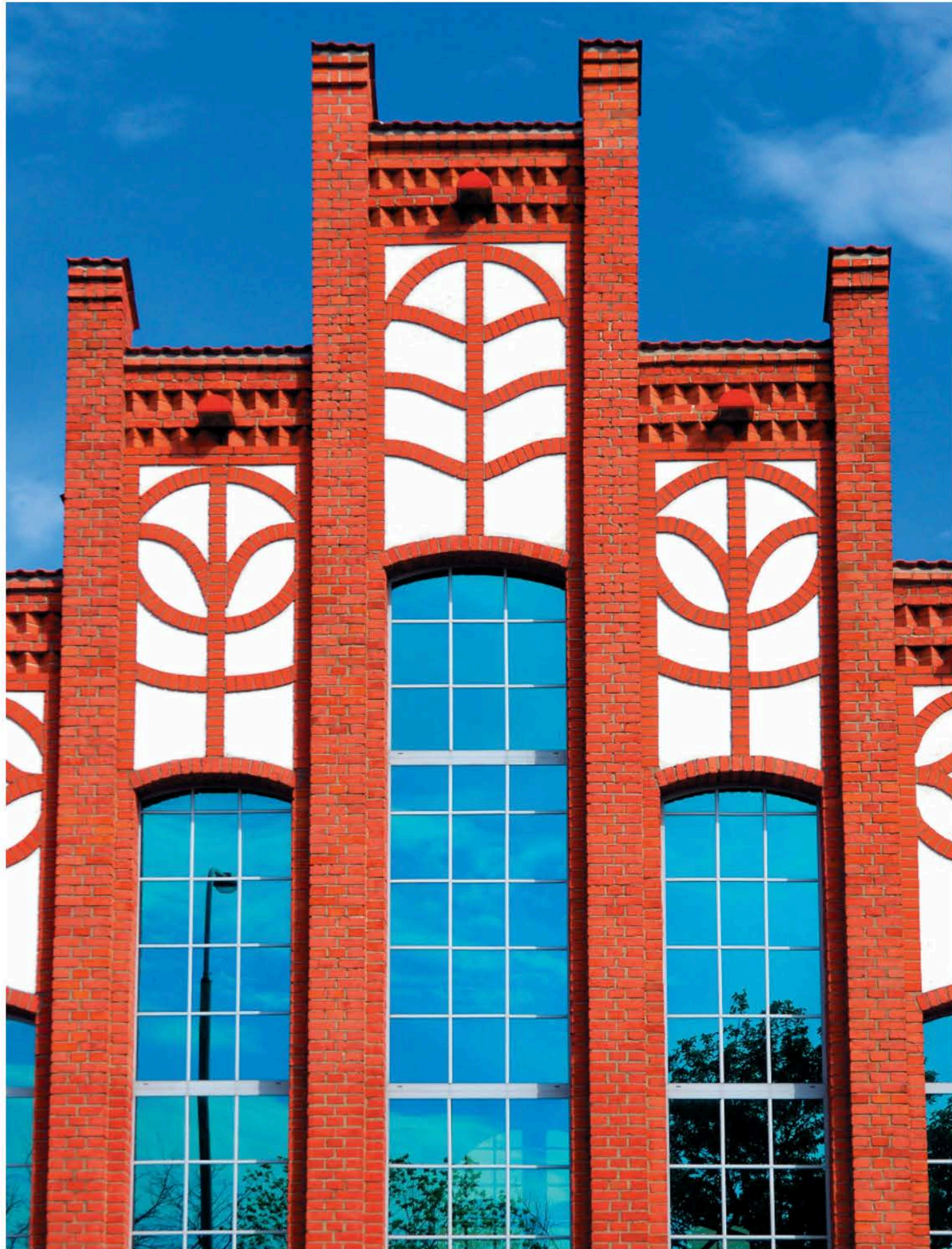
Przepompownia ścieków przy ul. Garbary w Poznaniu – fasada frontowa (foto M. Kucharczyk)
