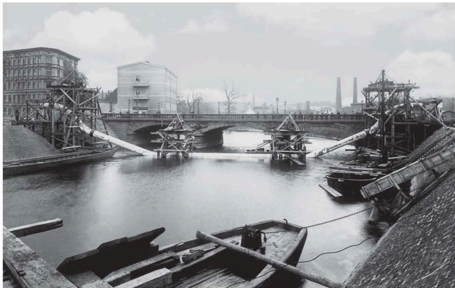
Budowa rurociągu z Zakładu Uzdatniania Wody „Na Grobli” we Wrocławiu przez rzekę Oławę – 1937 r. (arch. MPWiK Wrocław)
