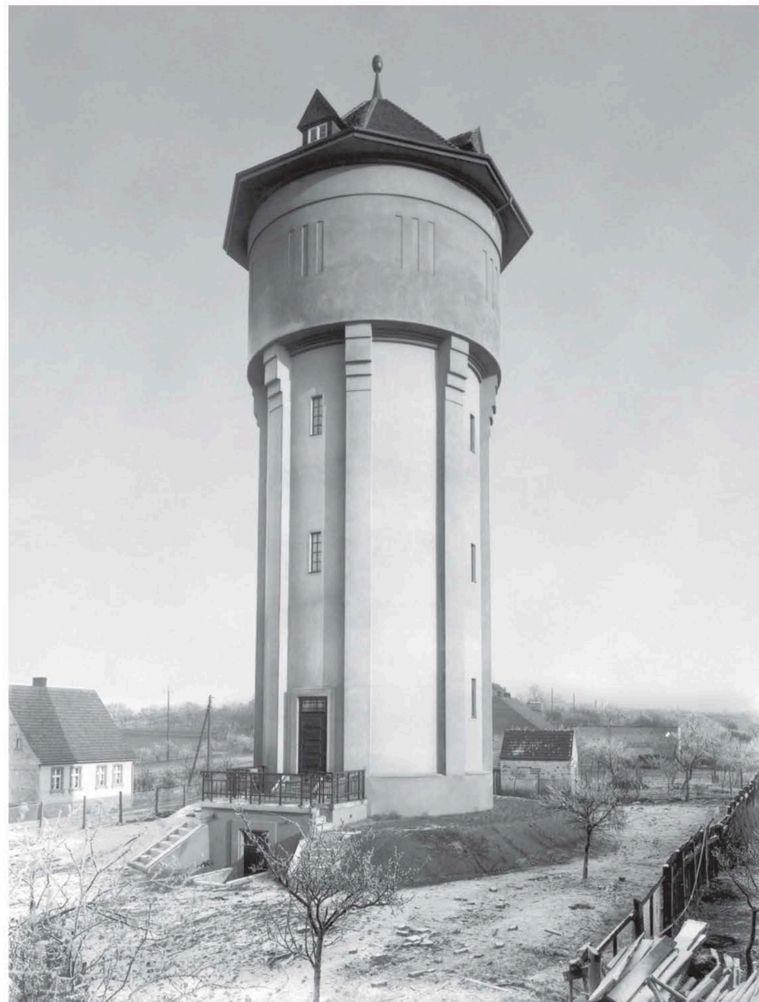
Zielona Góra. Zbiornik wieżowy przy ul. Kordiana – 1928 r. (arch. Zielonogórskie Wodociągi i Kanalizacja)
