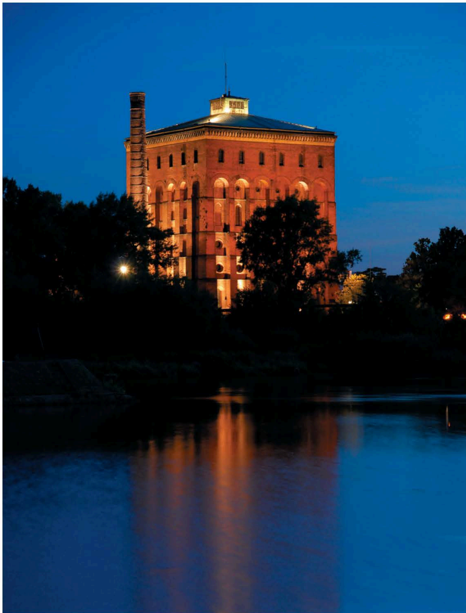
Pochodząca z 1871 r. wieża ciśnieniowa jest jedną z najbardziej charakterystycznych wrocławskich budowli (foto M. Kucharczyk)
