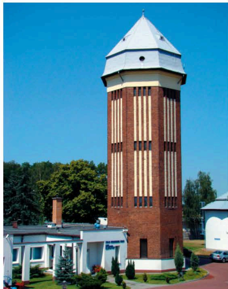
Nowy Tomyśl, woj. wielkopolskie – wieża ciśnieniowa z 1906 r., wysokość 32 m, zbiornik 100 m 3 , stacja pomp tłokowych napędzanych silnikami na gaz miejski (foto P. Janik)
