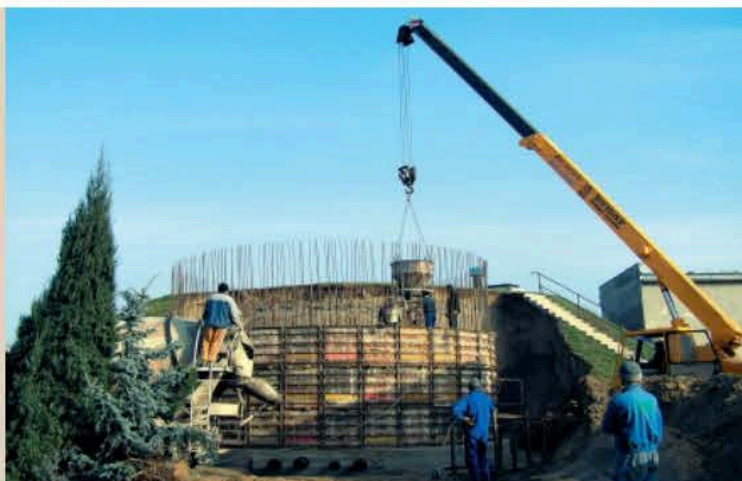
SUW Sitnicka – budowa zbiornika technologicznego
