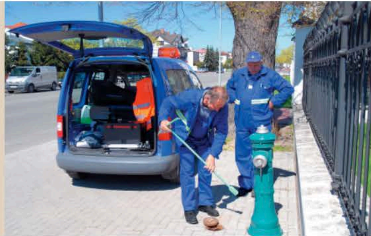
Zespół Pogotowia Wodno-Kanalizacyjnego podczas rutynowego przeglądu hydrantów
