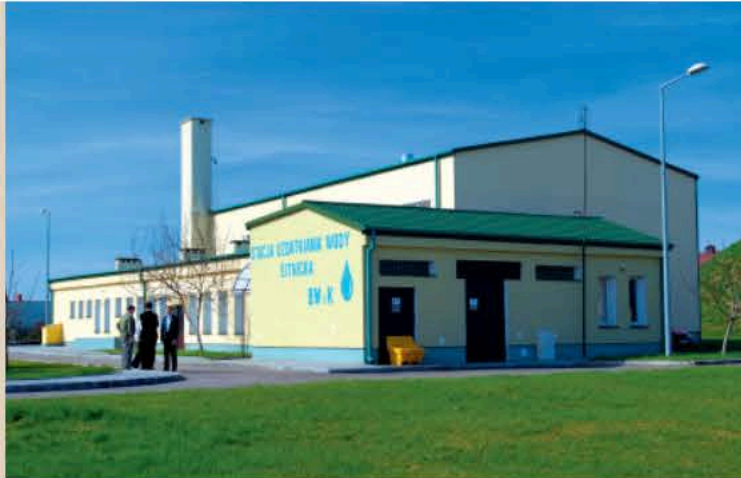
Budynek Stacji Uzdatniania Wody Sitnicka
