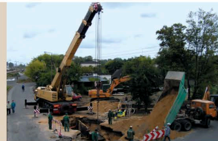
Budowa kanalizacji w ulicy Dokudowskiej
