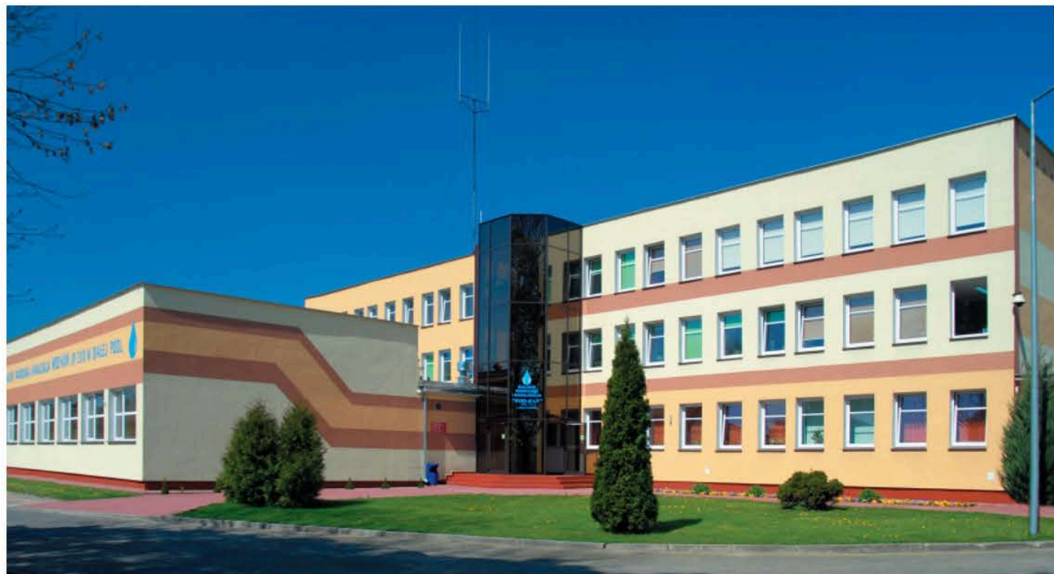
Siedziba Spółki przy ul. Narutowicza została w roku 2008 nominowana do tytułu „Modernizacja Roku”
