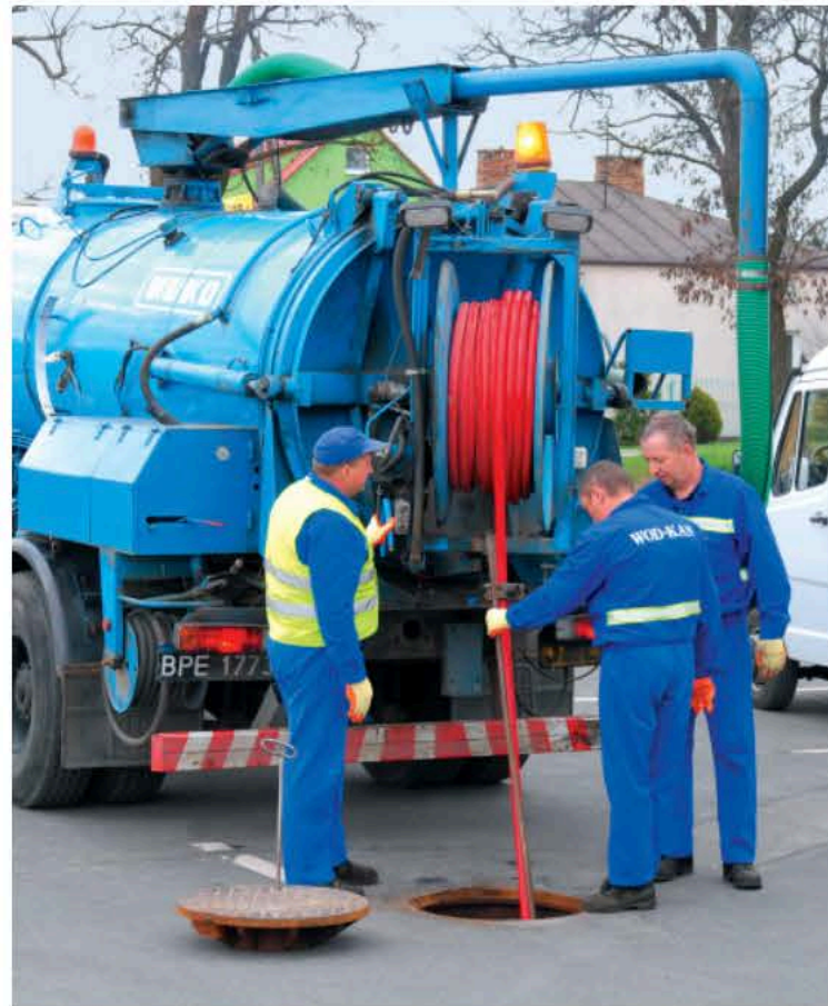
Czyszczenie kolektorów ściekowych zapewnia utrzymanie drożności systemu
