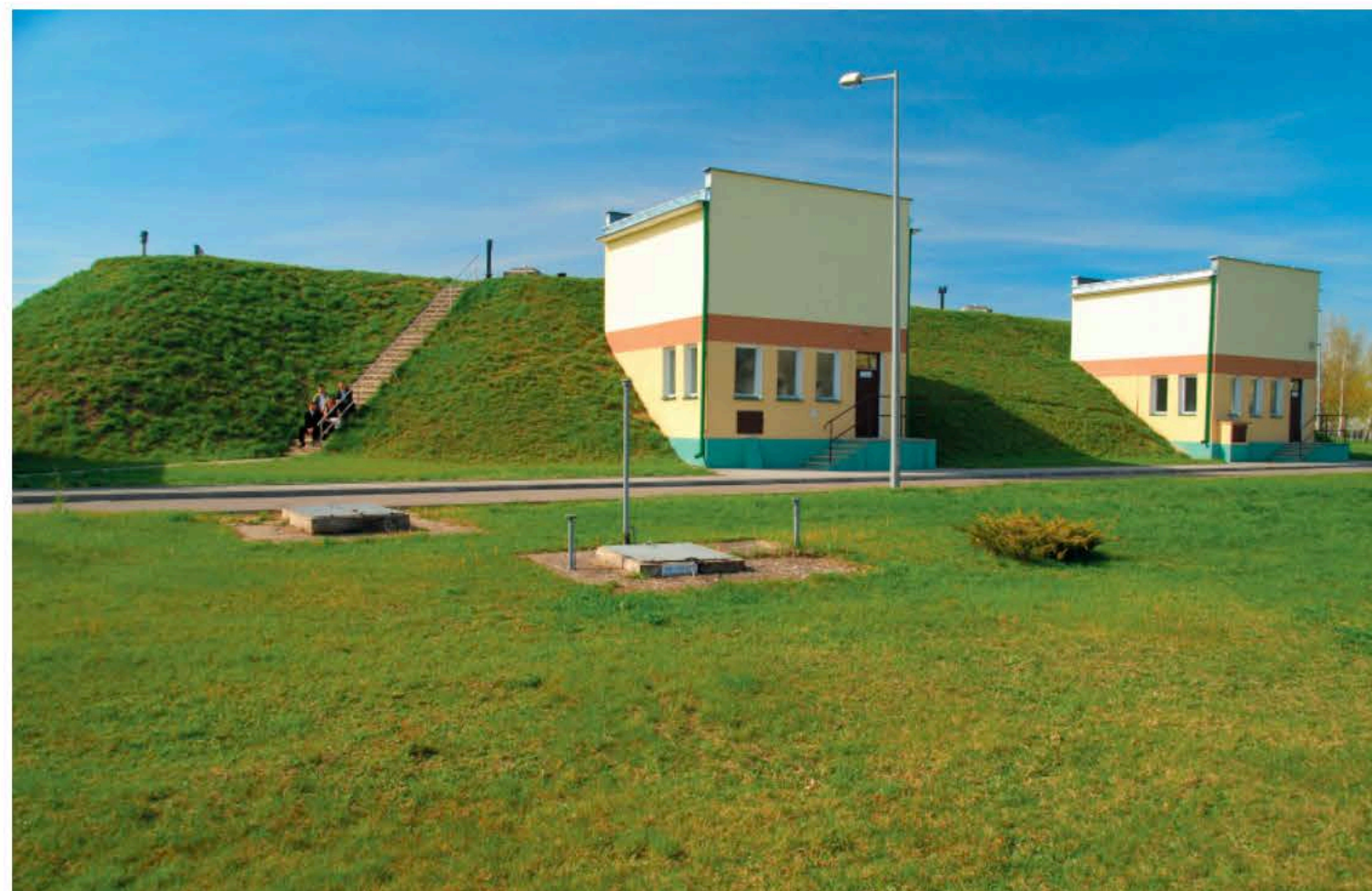
SUW Sitnicka – widok na zbiorniki wody
