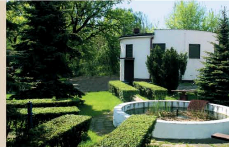
Przepompownia ścieków przy ul. Mickiewicza
