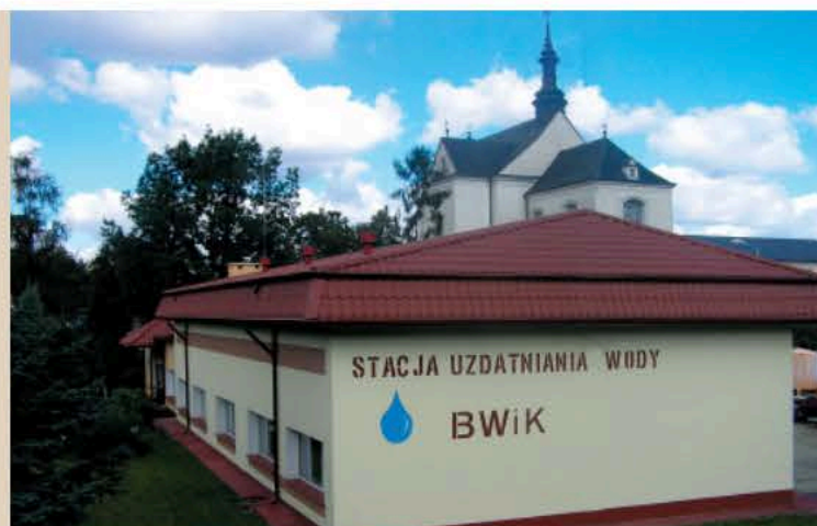
Budynek Stacji Uzdatniania Wody Narutowicza
