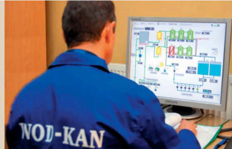
Monitorowanie procesów uzdatniania wody w SUW Sitnicka
