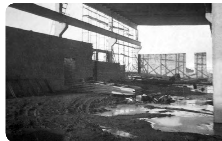
Pierwsze ściany Zakładu Generatorów / Original walls of the Generator Unit
