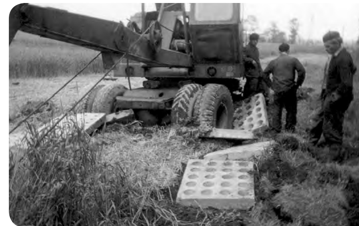
Plac budowy Bazy Remontowej Energetyki / Construction of the Overhaul Base of Power Industry
