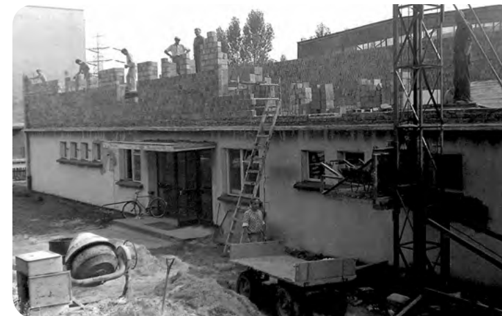
Budowa warsztatów szkolnych / Construction of school's workshops
