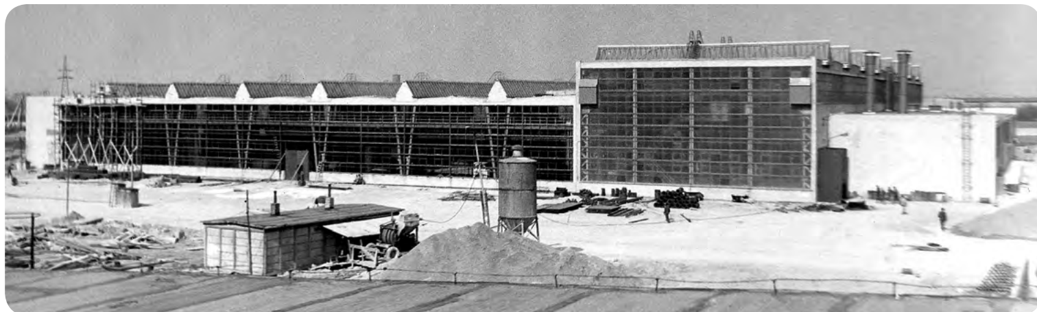
Hala Zakładu Mechanicznego w trakcie budowy / Mechanical Unit under construction
