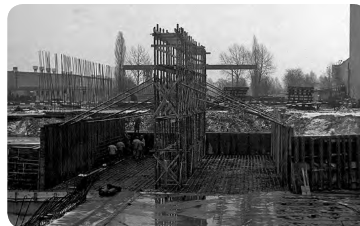
Budowa odwirowni / Construction of the rotor plant
