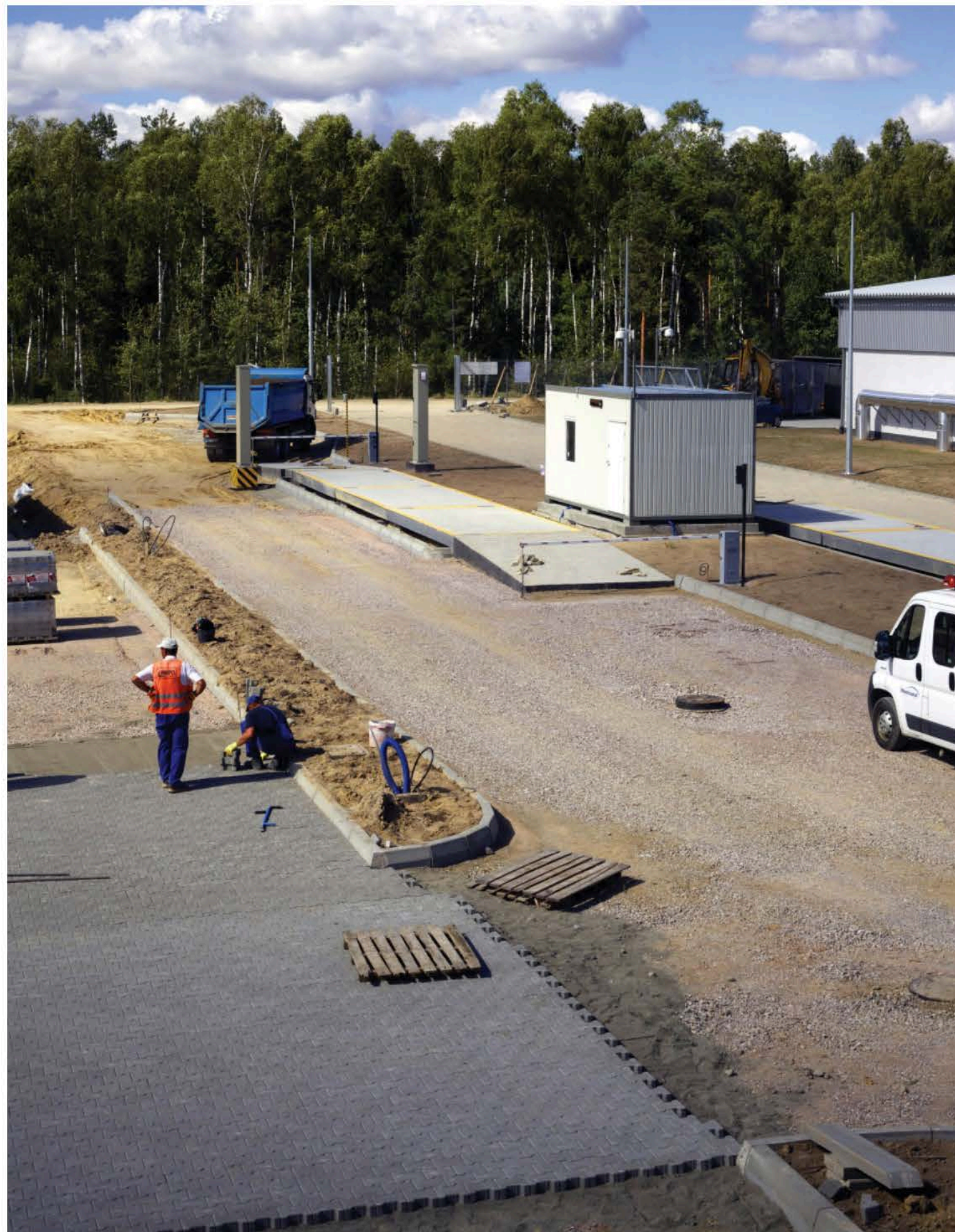
Postęp w pracach przebiegał zgodnie z harmonogramem budowy, wrzesień 2013 r.
