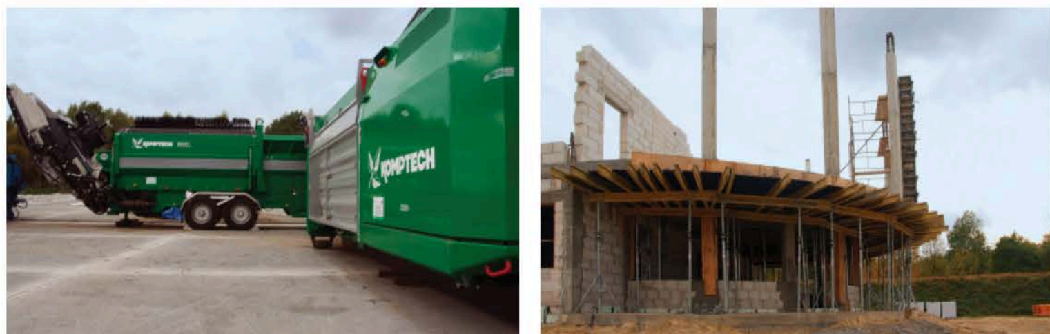
Plac budowy Zakładu Zagospodarowania Odpadów, październik 2012 r.
