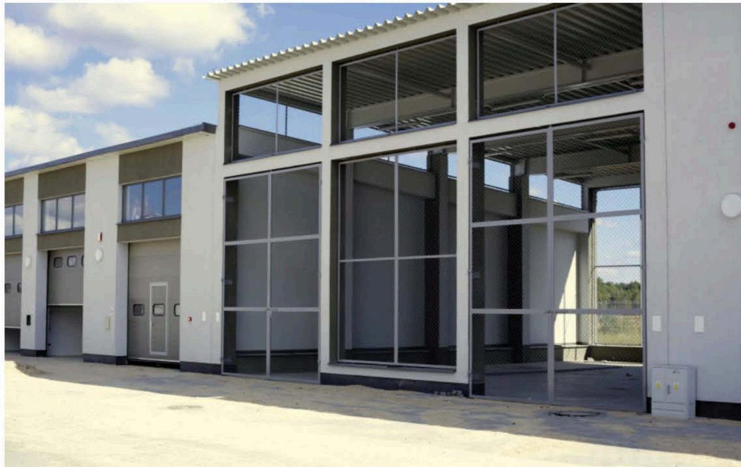
Budynek warsztatowo-garażowy oraz magazyn małych ilości odpadów niebezpiecznych, wrzesień 2013 r.
