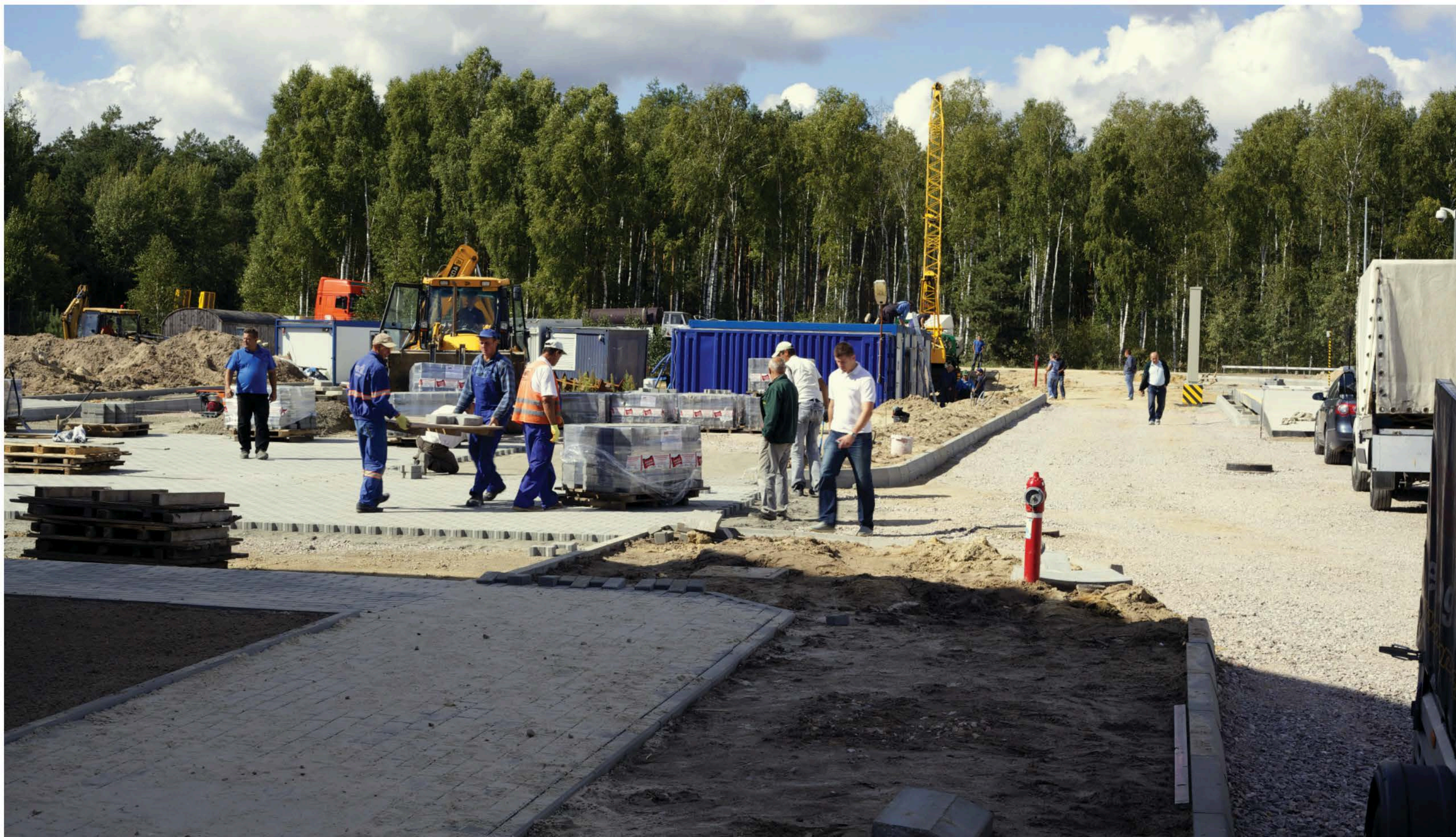
Plac budowy, wrzesień 2013 r.
