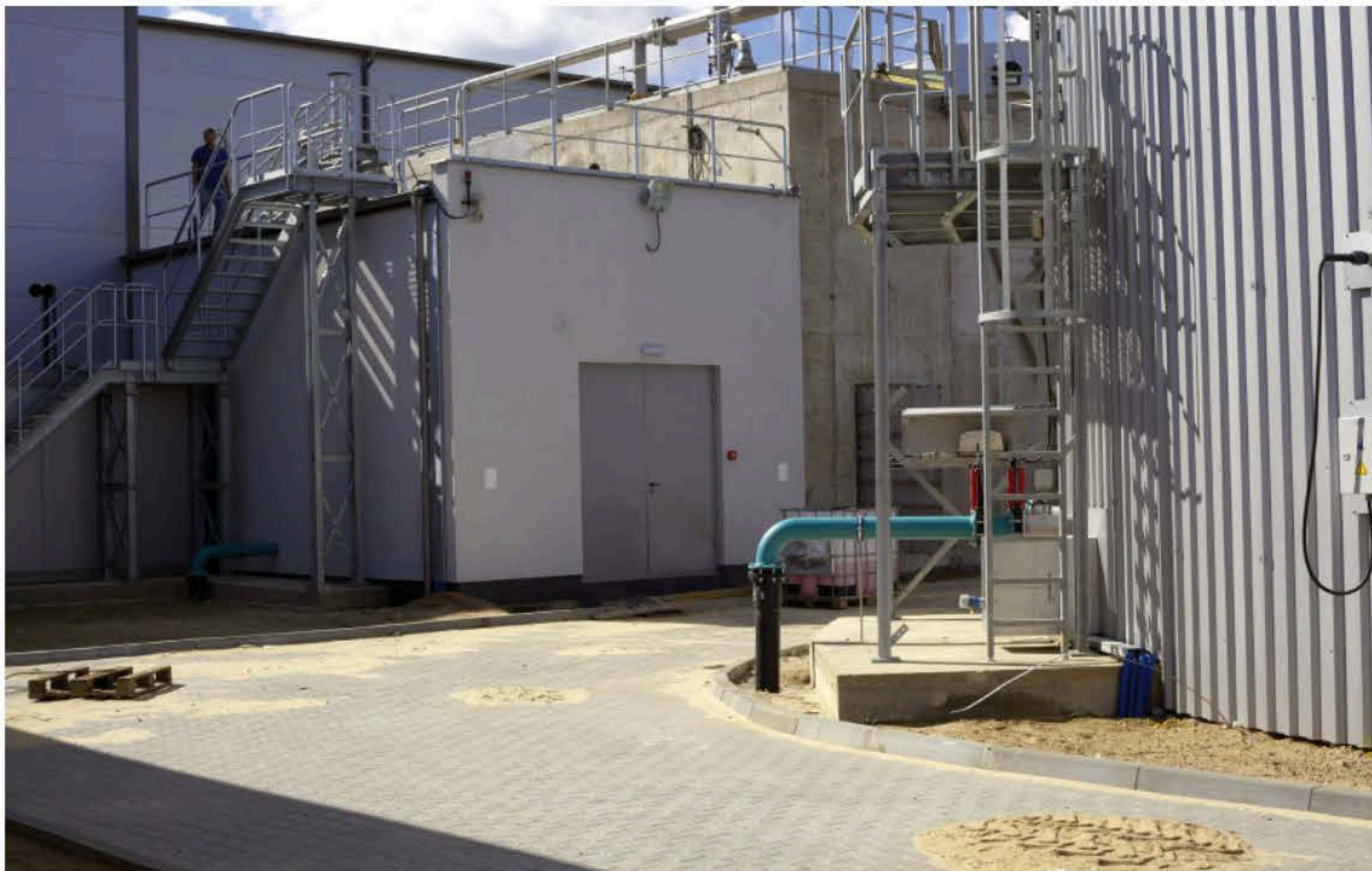
Plac budowy, wrzesień 2013 r.
