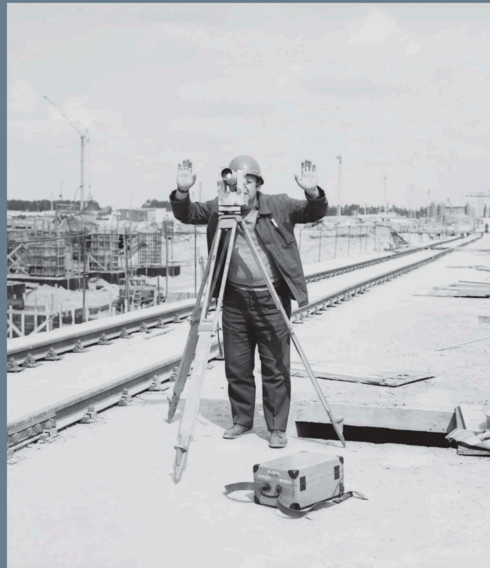
Fot.: Prace miernicze na budowie
