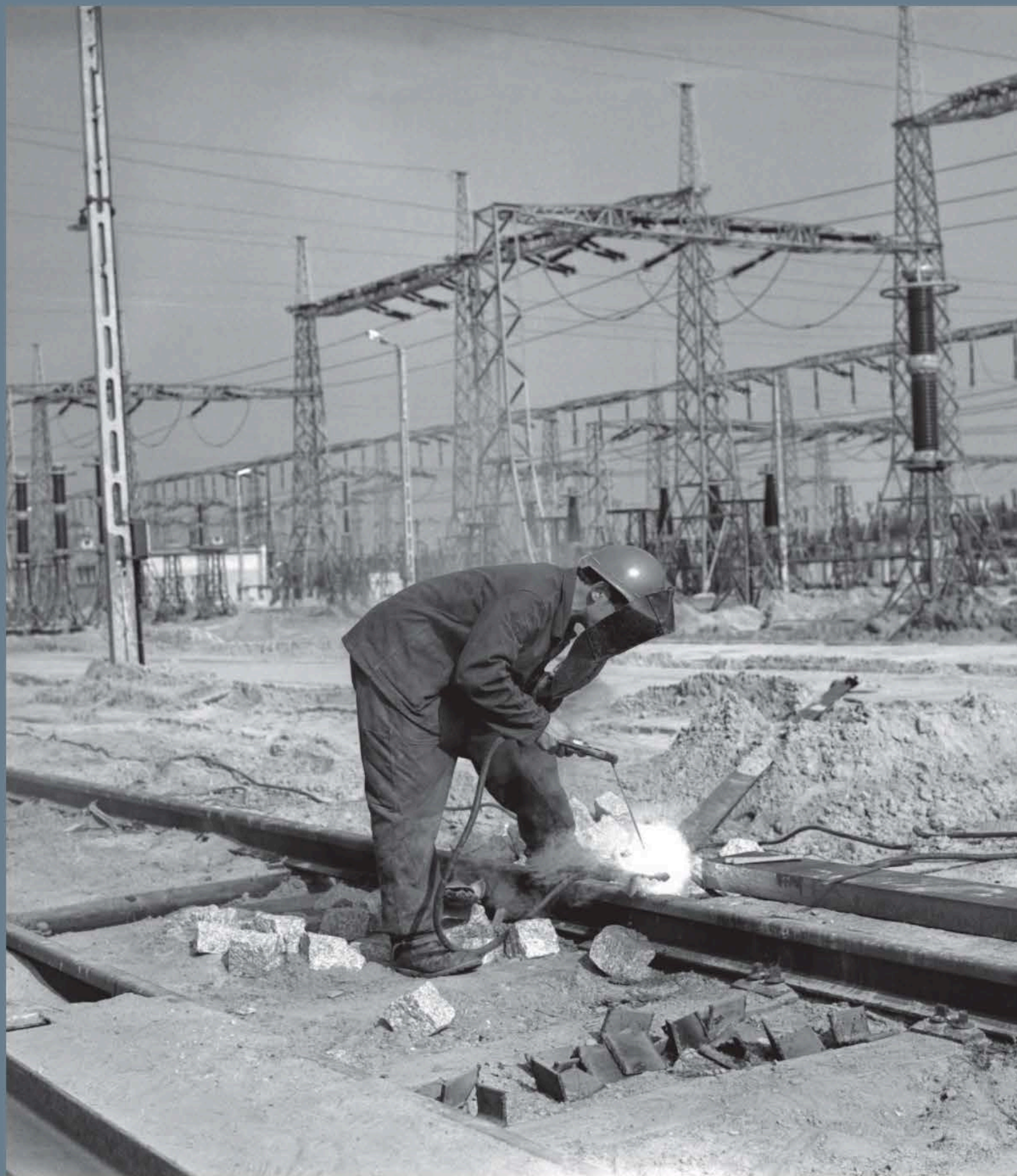
Fot.: Spawanie torów bocznic kolejowej
