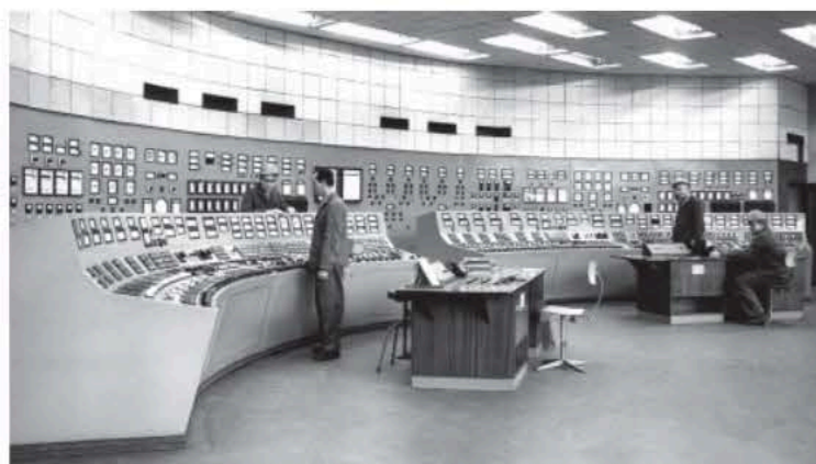
Nastawnia bloków 120 MW – lata 70. XX w. / 120 MW power units control room – 1970s
