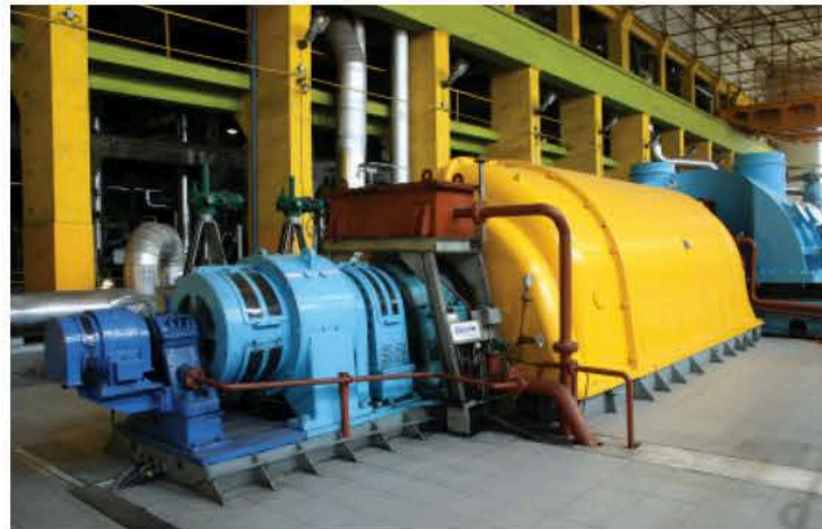
Widok najnowszej turbiny nr 6. Na początku lat 80. wysłużone turbiny Škoda zostają wymienione na turbiny produkcji ZAMECH Elbląg; po prawej: turbina TK120, 120 MW / View of the latest turbine No. 6. In the early 1980s the worn-out Škoda turbines were replaced with turbines produced by ZAMECH Elbląg; on the right: TK120 turbine, 120 MW
