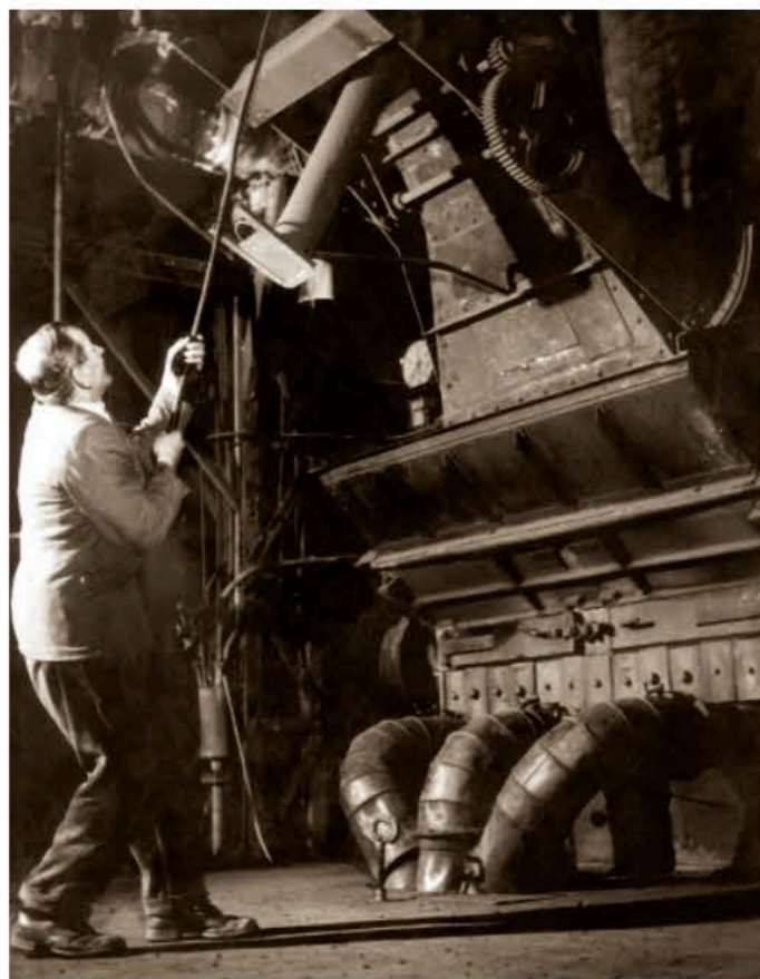
Elektrownia Siersza Wodna – kotłownia, lata 50. XX w. / Siersza Wodna Power Plant – boiler house, 1950s
