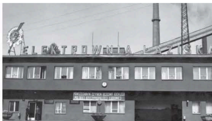
Brama wejściowa elektrowni – lata 70. XX w. / Power plant entrance gate – 1970s
