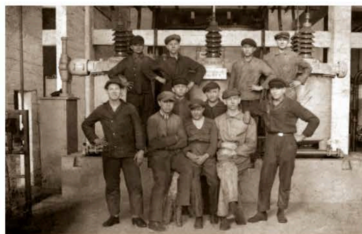
Pracownicy elektrowni na tle rozdzielni 60 kV – 1938 r. Obecnie rozdzielnia mieści Muzeum Energetyki / Power plant workers in front of a 60 kV switching station. At present the station houses the Museum of Power Industry
