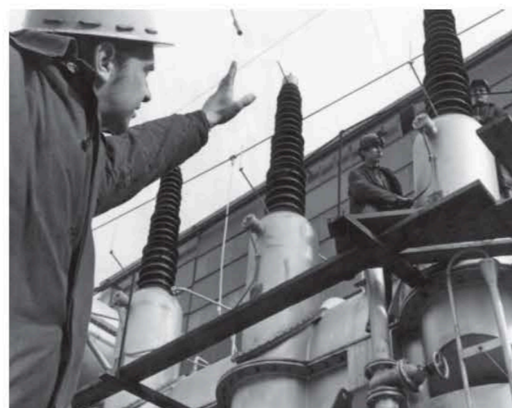
Prace przy transformatorze ostatniego bloku – 1970 r. / Works on the last unit's transformer – 1970
