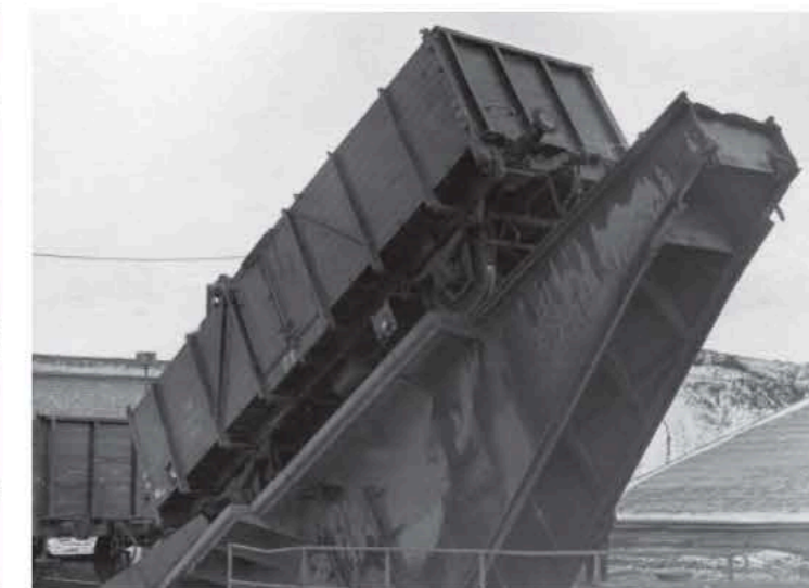
Wyrotnica wagonowa czołowa – 1962 r. / End-discharge wagon tippler – 1962
