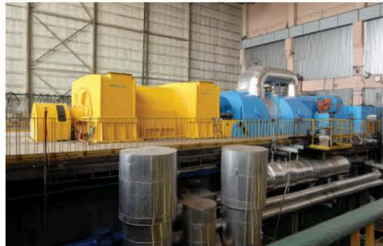
Widok najnowszej turbiny nr 6. Na początku lat 80. wysłużone turbiny Škoda zostają wymienione na turbiny produkcji ZAMECH Elbląg; po prawej: turbina TK120, 120 MW / View of the latest turbine No. 6. In the early 1980s the worn-out Škoda turbines were replaced with turbines produced by ZAMECH Elbląg; on the right: TK120 turbine, 120 MW
