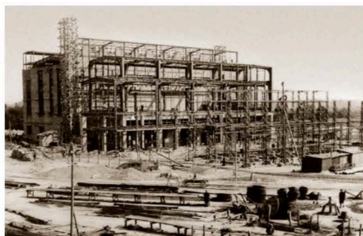
Powstająca konstrukcja maszynowni, kotłowni i suwnicy żużlowej – 1938 r. The emerging structure of the engine house, boiler house and slag handling crane – 1938
