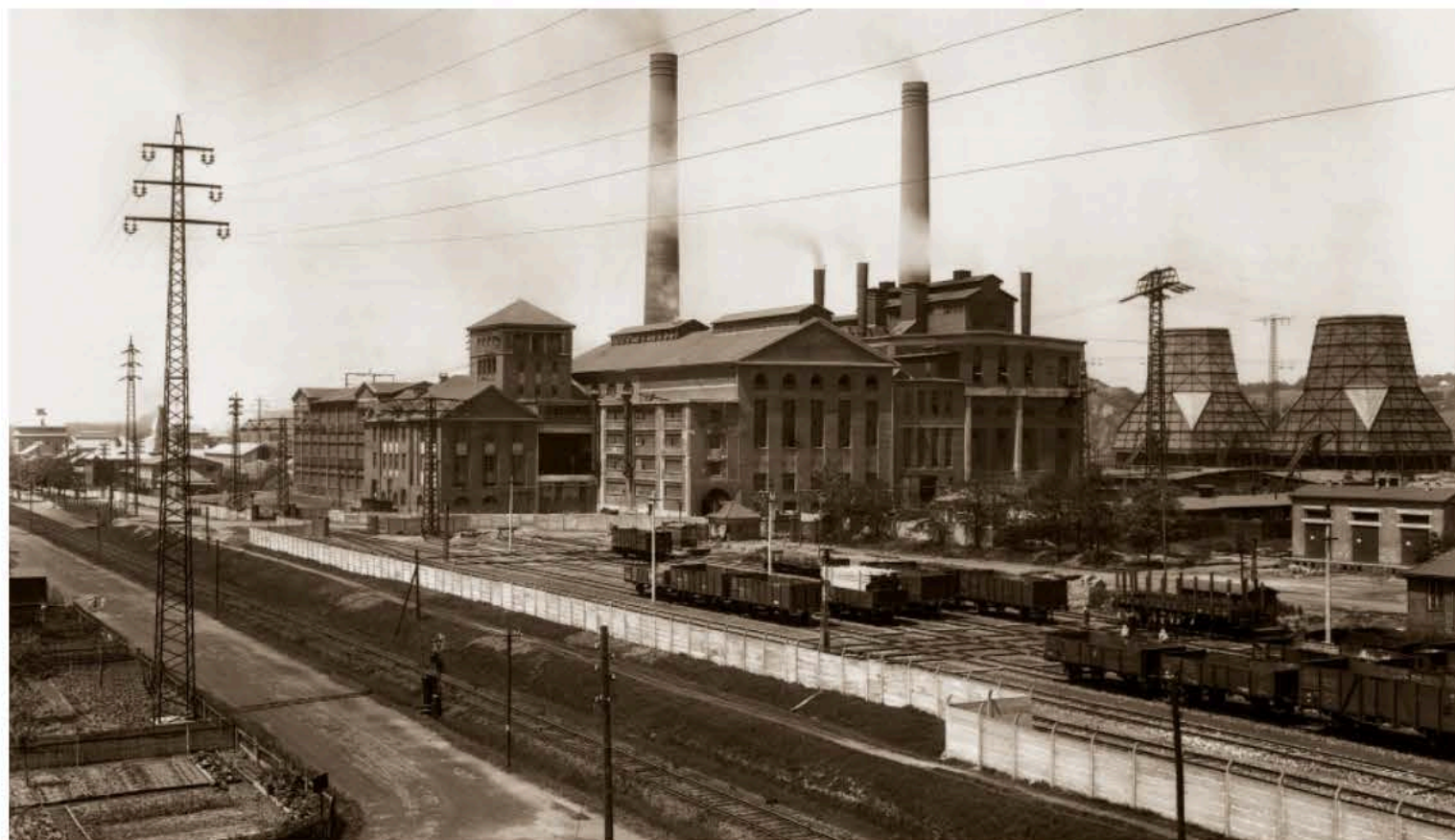
Elektrownia po rozbudowie w 1929 r. Od lewej – rozdzielnia 60 kV, rozdzielnia 6 i 20 kV, maszynownia, kotłownia, chłodnie kominowe. Wagony na bocznicę kopalni Książętko / The power plant after expansion in 1929. On the left: 60 kV substation, 60 and 20 kV substations, engine house, boiler house, cooling towers. Rail cars on a siding at the Książętko Mine
