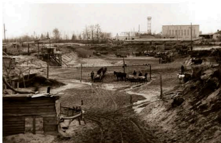
Budowa ujęcia wodnego dla obiegu chłodzenia kondensatorów turbin – 1938 r. / Construction of a water intake for turbine condensators cooling circulation – 1938
