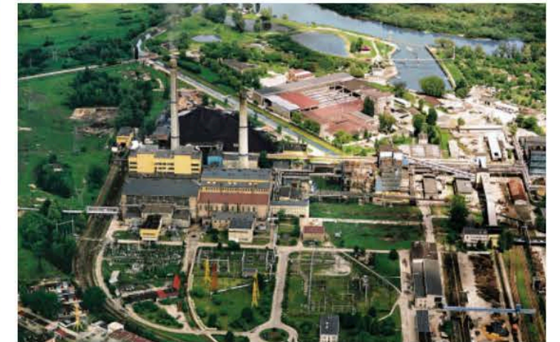
Widok siłowni z lotu ptaka po wyburzeniu elektrowni I – 2005 r. / A bird's eye view of the powerhouse after the demolition of power plant I – 2005
