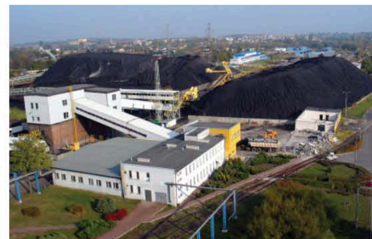
Składowisko węgla i system nawęglania / Coal yard and stoking system
