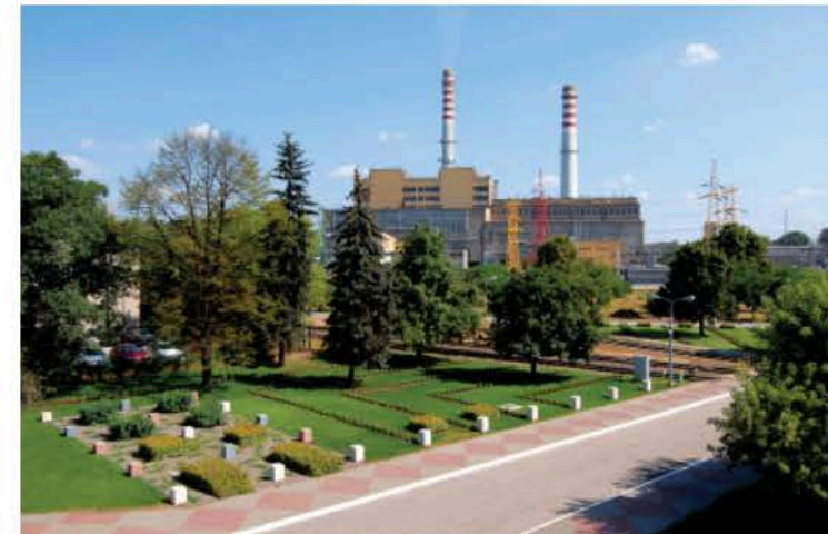
Elektrownia Stalowa Wola – sierpień 2008 r. / The Stalowa Wola Power Plant – August 2008
