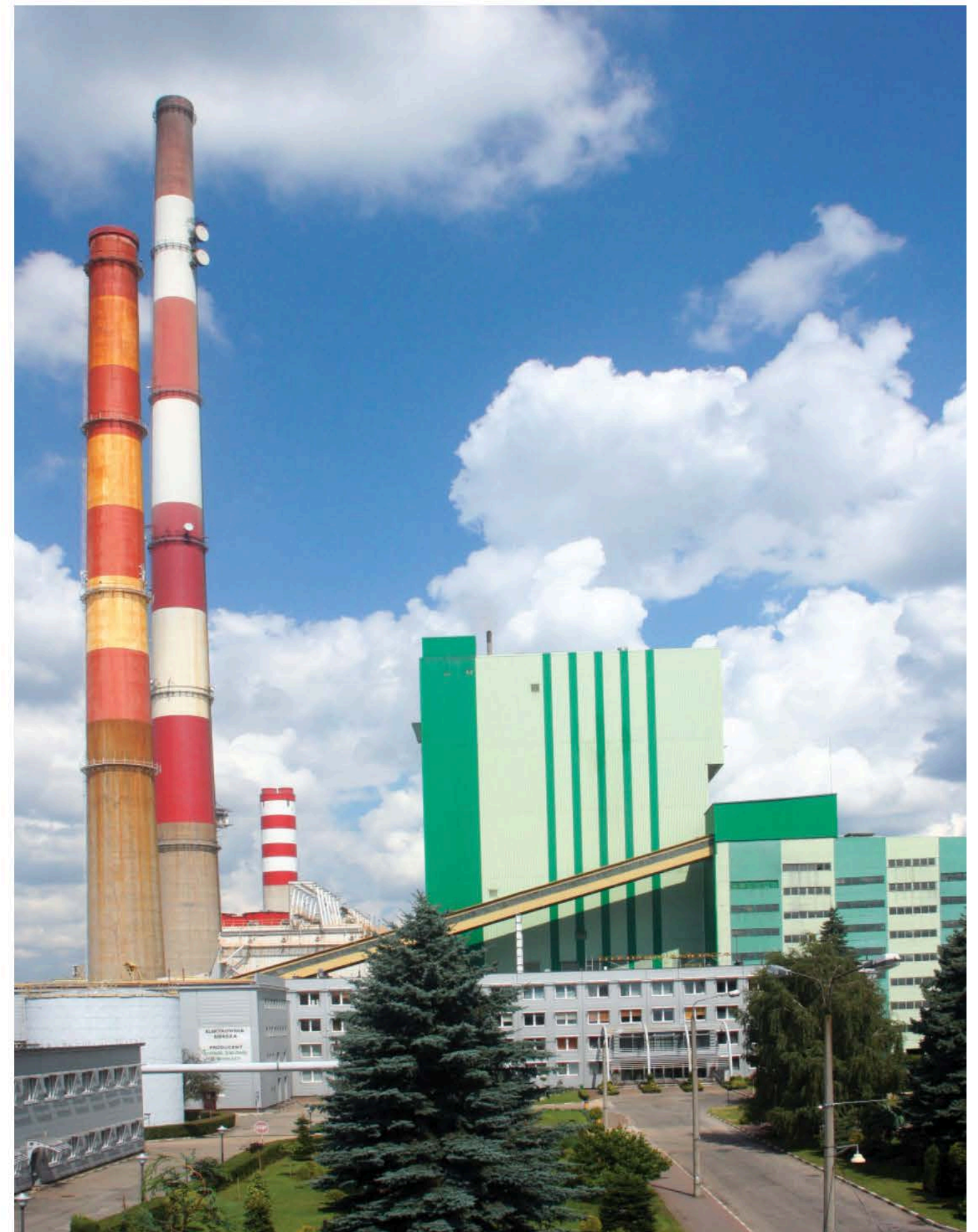
Elektrownia Siersza w Trzebinii – współcześnie / The present Siersza Power Plant in Trzebinia
