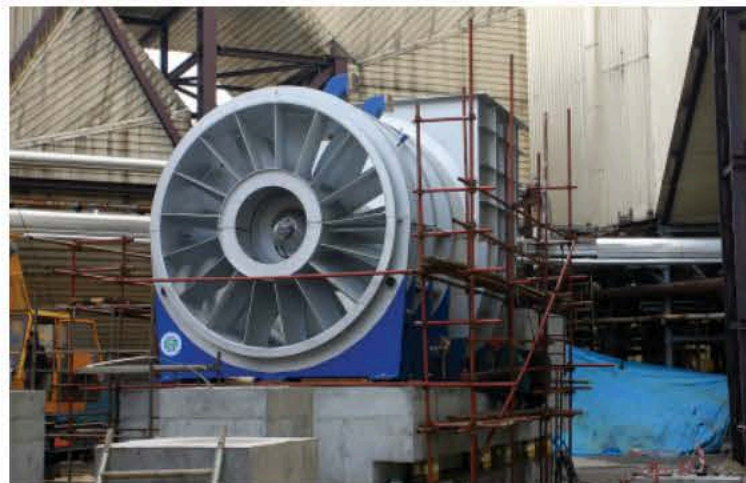
Jaworznińska instalacja odsiarczania spalin. Na zdjęciach budowa wentylatora spalin – 2008 r. / The flue gas desulphurisation plant in Jaworzno. In the photos: construction of a flue gas fan – 2008
